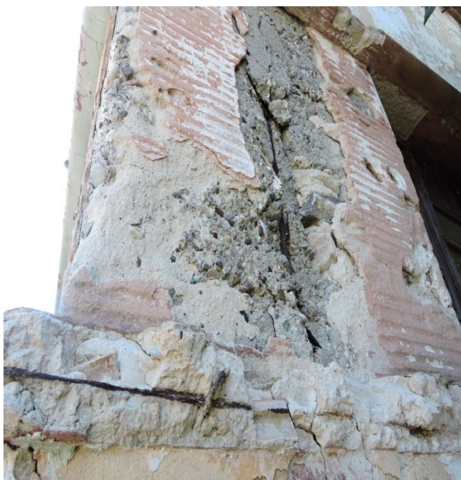
Εικ. 34 & 35 Διάβρωση -αποφλοιώσεις
