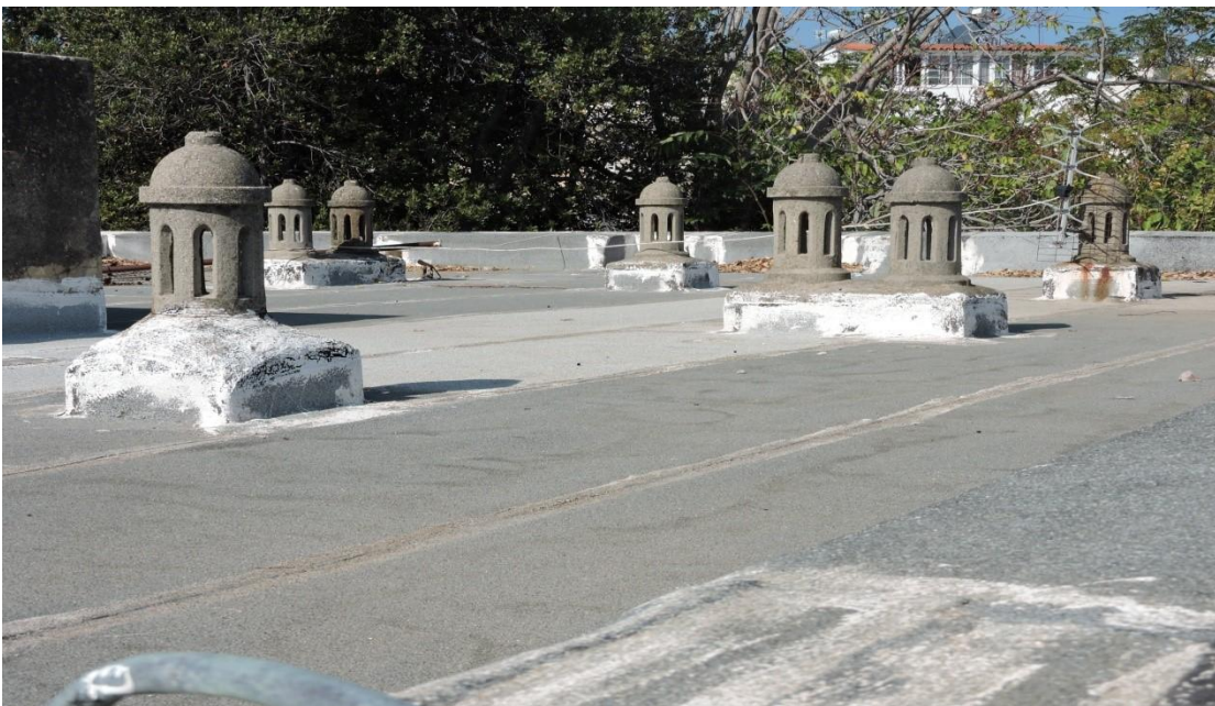
Εικ. 32. Το δωμα –Απόληξη αεραγωγ
