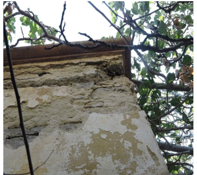
Εικ. 36 & 37 Σοβαρές απώλειες υλικού στις εξωτερικές όψεις του κτιρίου
