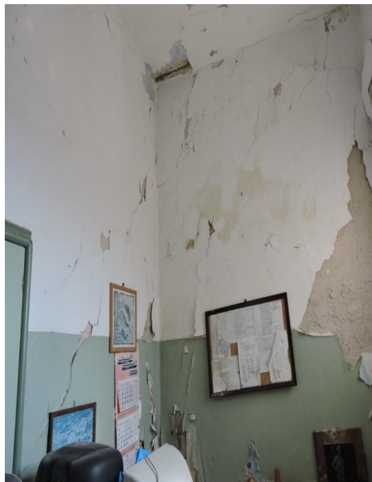
ΕΙΚ. 33. Κάθετη ρωγμή στην νοτιοανατολική πλευρά όπως διακρίνεται εσωτερικά και εξωτερικά.
