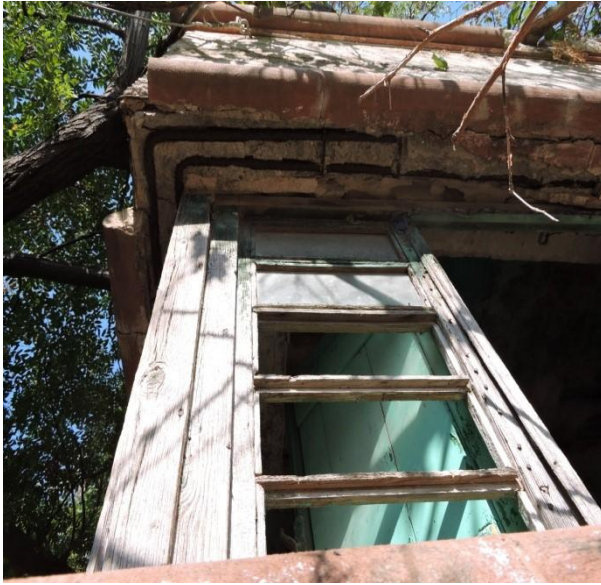
Εικ. 36 & 37 Σοβαρές απώλειες υλικού στις εξωτερικές όψεις του κτιρίου
