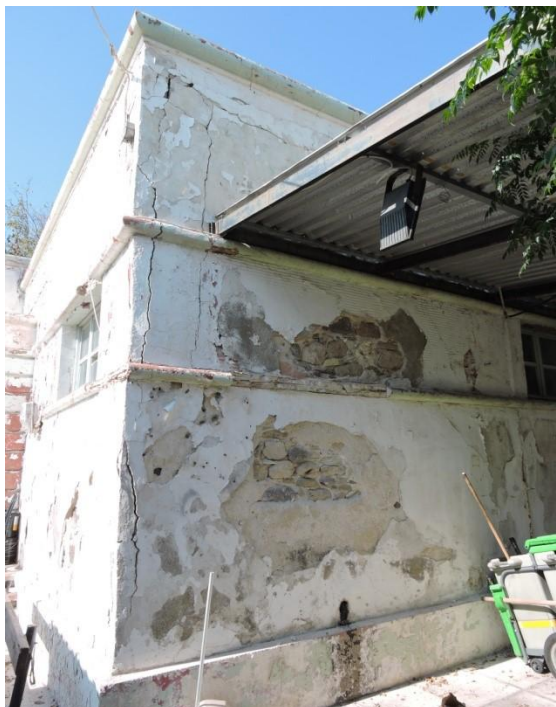
ΕΙΚ. 33. Κάθετη ρωγμή στην νοτιοανατολική πλευρά όπως διακρίνεται εσωτερικά και εξωτερικά.
