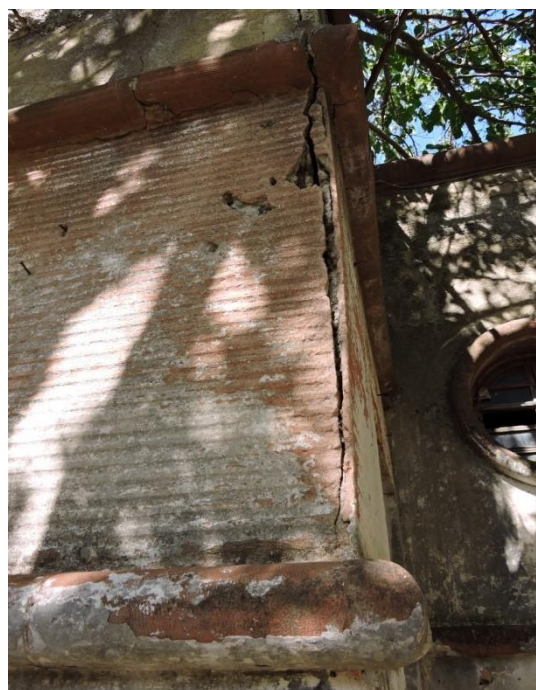
ΕΙΚ. 33. Κάθετη ρωγμή στην νοτιοανατολική πλευρά όπως διακρίνεται εσωτερικά και εξωτερικά.
