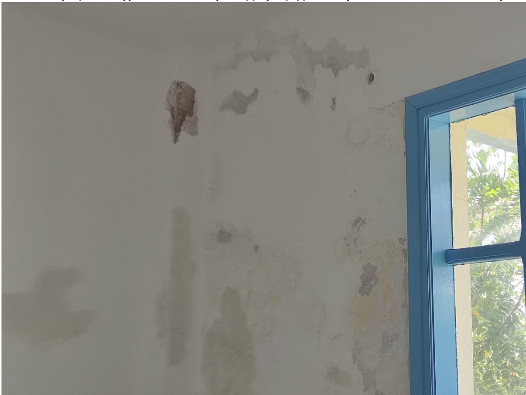
Εικ 6. Φθορές από υγρασία στον σοβά του τοίχου εσωτερικά, νοτιοδυτικά του κτιρίου.
