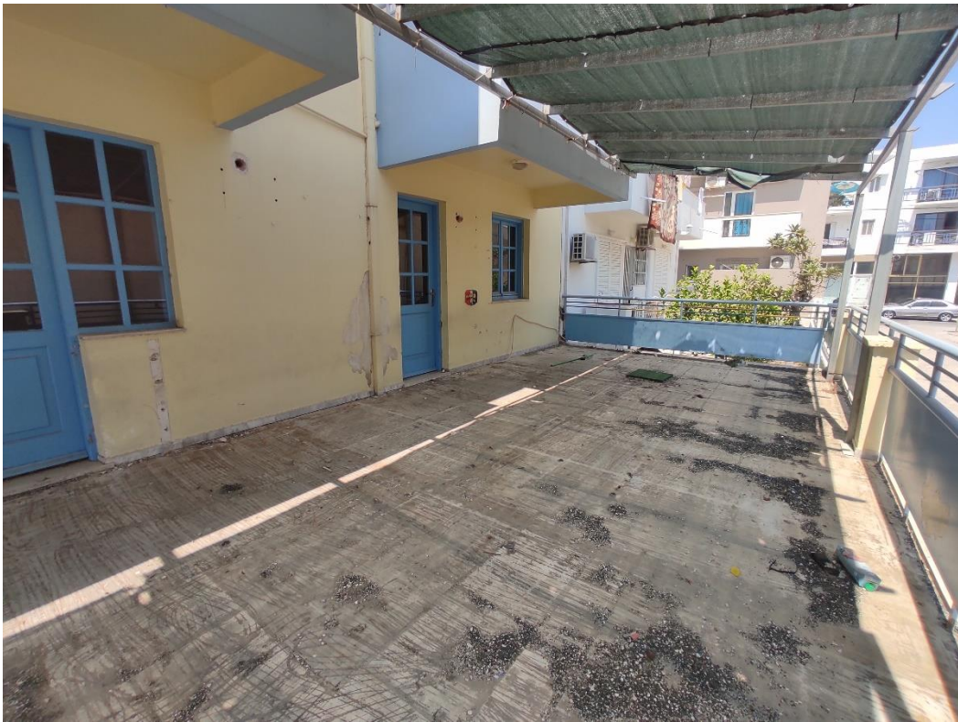
Εικ 1. Ανατολική όψη του κτιρίου
