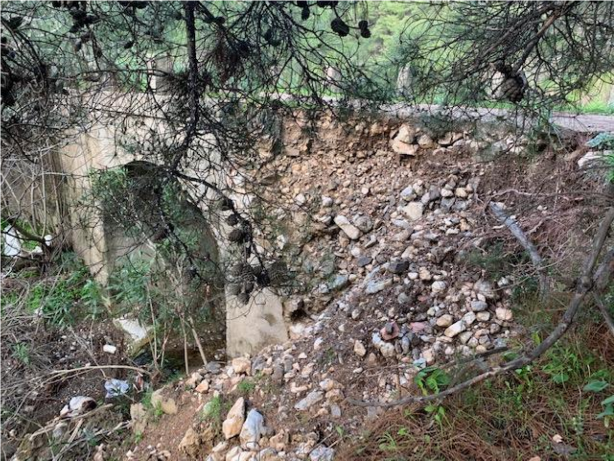
Εικόνα 2: άποψη γεφυριού Νοτιανατολικά (κατάντη)
